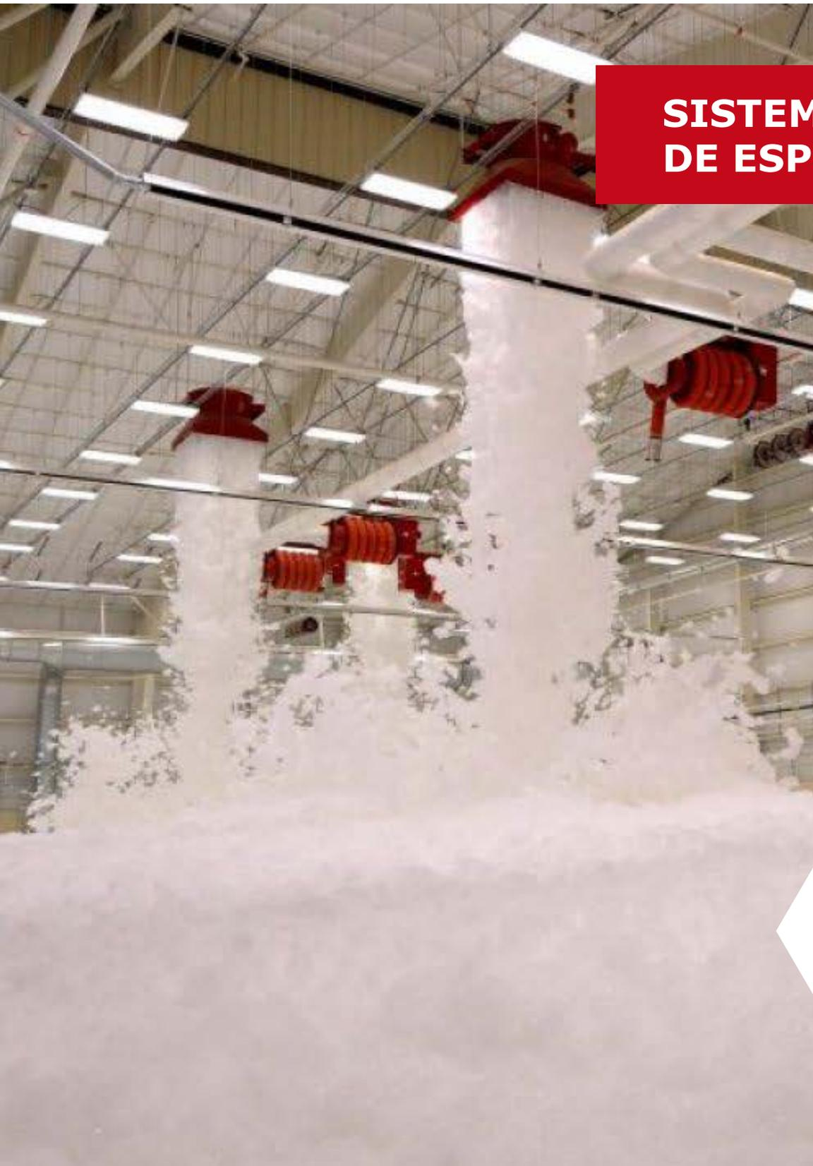
El sistema de espuma para extinción de incendios funciona mediante la creación de una barrera entre el oxígeno y el combustible, lo cual sofoca el fuego y evita que el líquido inflamable libere vapores que podrían reignitar.
